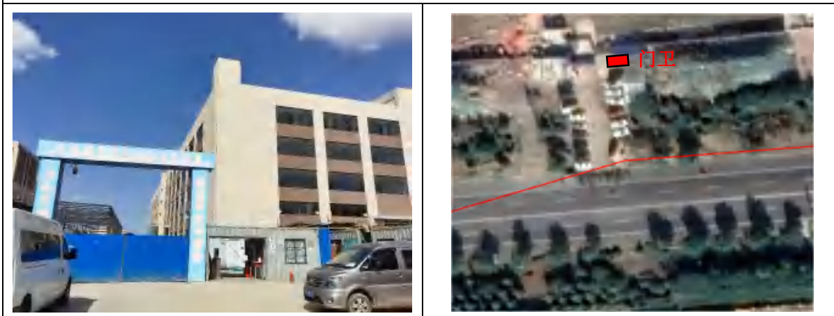
图 2-3 江苏华衡电力科技有限公司门卫室
